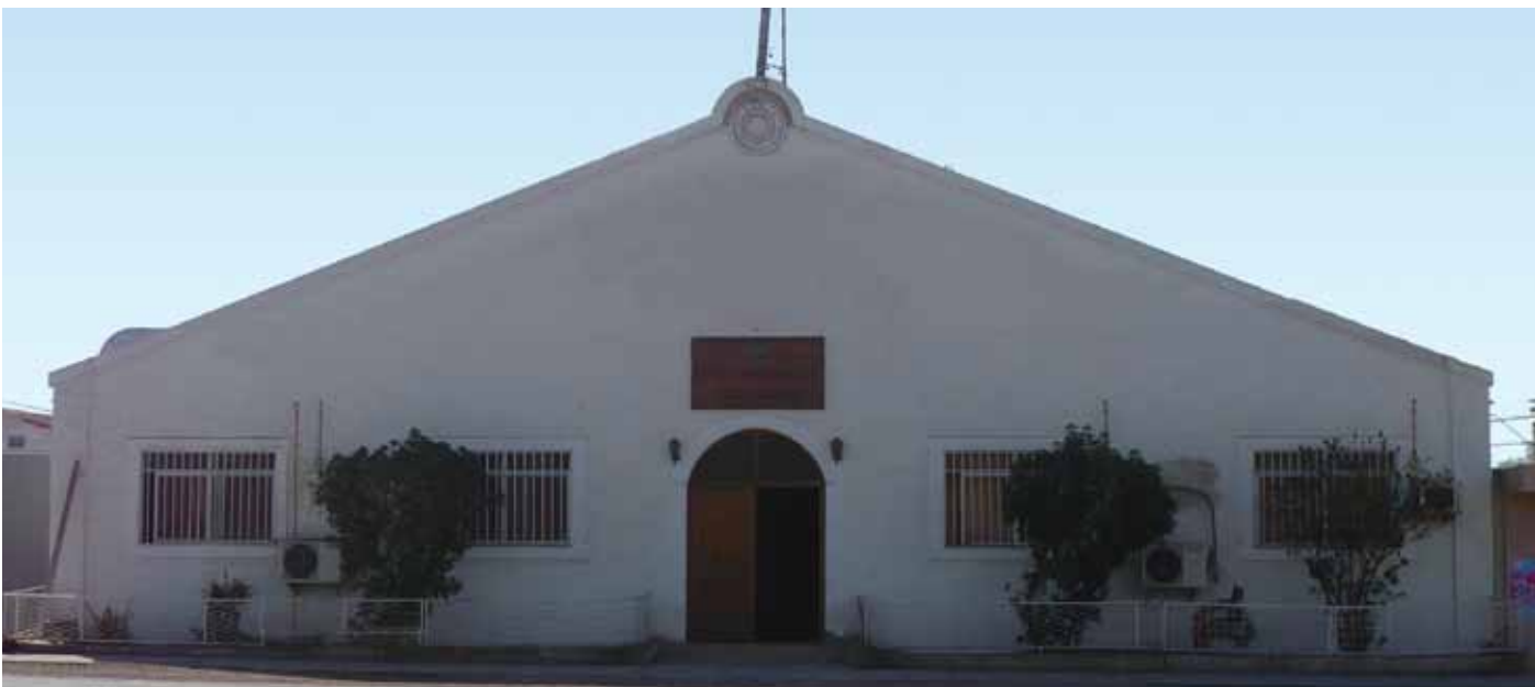
HOSPITAL / MERCADO / BIBLIOTECA
