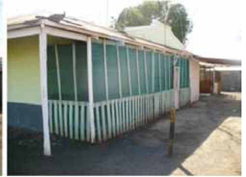
AMPLIACION CON SOMBREADERO
